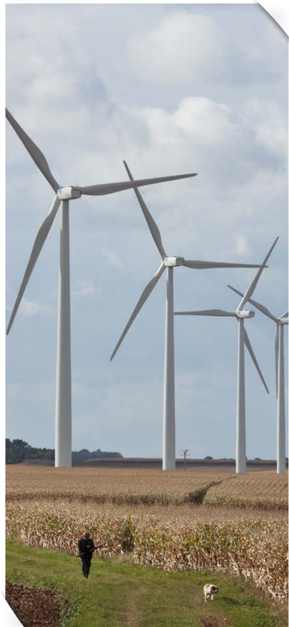
Parc éolien du Rochereau, Région Poitou-Charente
